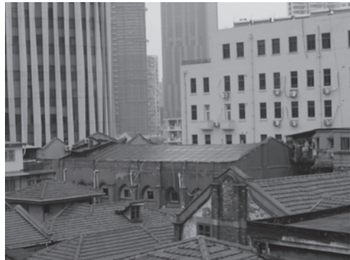
写真 22 老靶子路の建物・側面
