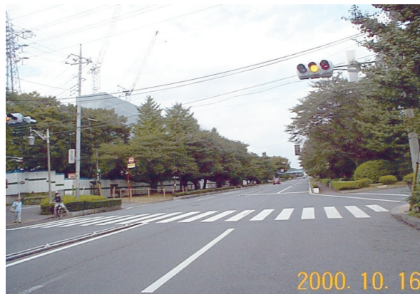
図2 左後方の白い建物が問題のマンション (建設中) 高さ 44 m, 14 階建てとして建設された (筆者撮影)。
